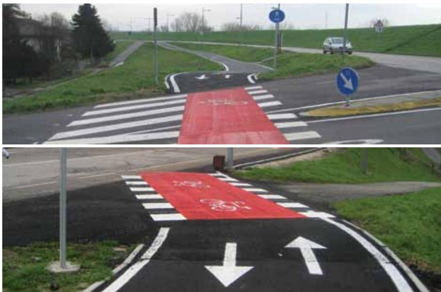
FIG2 Attraversamento ciclabile di viabilità principale
