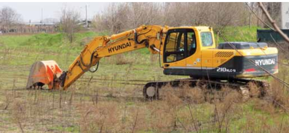
FIG2 Foto del cantiere
