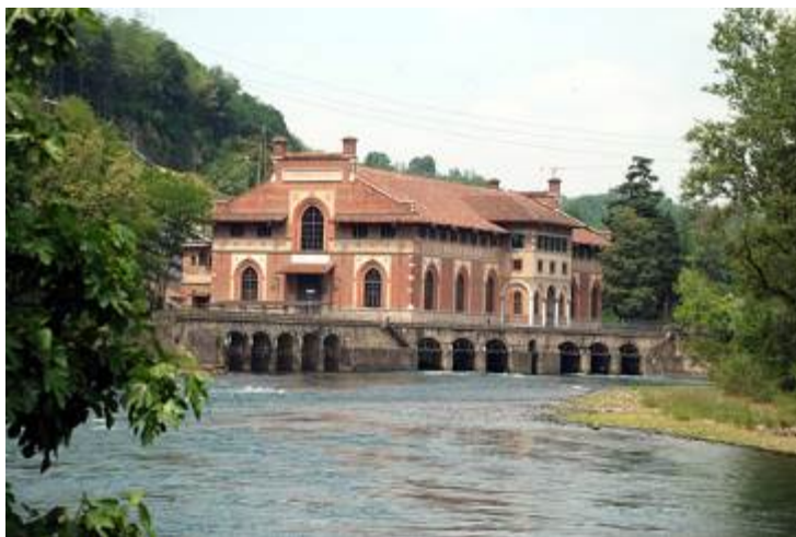
Centrale idroelettrica Edison "Carlo Esterle" (1906-14)
