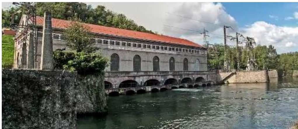
Centrale idroelettrica Edison "Angelo Bertini" (1895)
