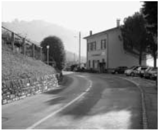
Dopo → intervento di messa in sicurezza e di moderazione del traffico
