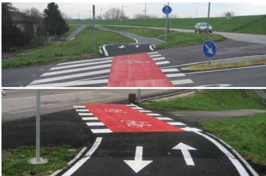
FIG2 Attraversamento ciclabile di viabilità principale
